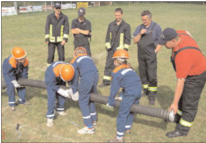
Kuppeln einer Saugleitung
