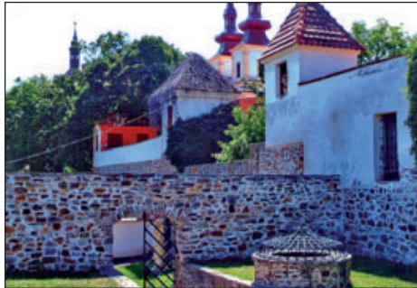
Teilansicht der östlichen Wehranlagen
